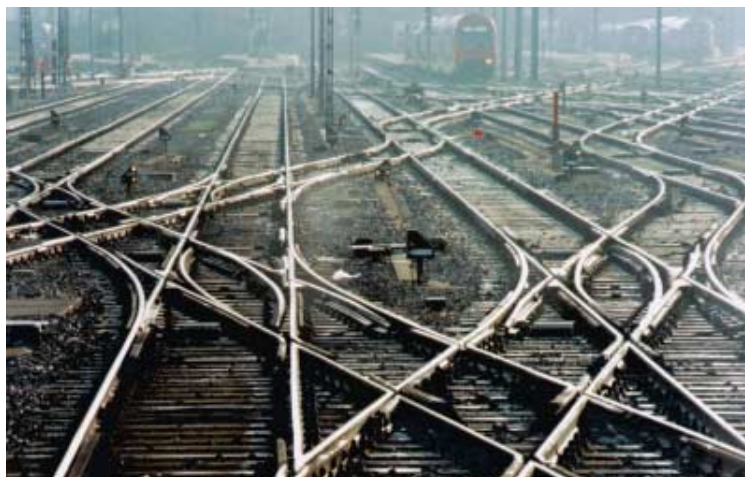
Auf dem richtigen Gleis an den richtigen Ort.
